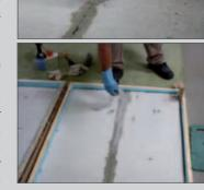
Text/Fotos: VDPM e. V. Bei den mit Rissen versehenen Probeflächen des zu sanierenden Estrichs handelte es sich um einen Calciumsulfat-Fließestrich "CAF-C25-F5-S45". Zum Zeitpunkt der Sanierung war der Calciumsulfat-Fließestrich belegreif (≤0,5 CM-%). Für die Sanierung der Risse wurde ein niedrigviskoses 2K-Reaktionsharz verwendet.
